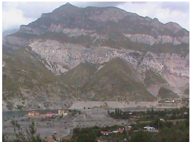
Der kleine Ort Komani unterhalb der Staumauer
